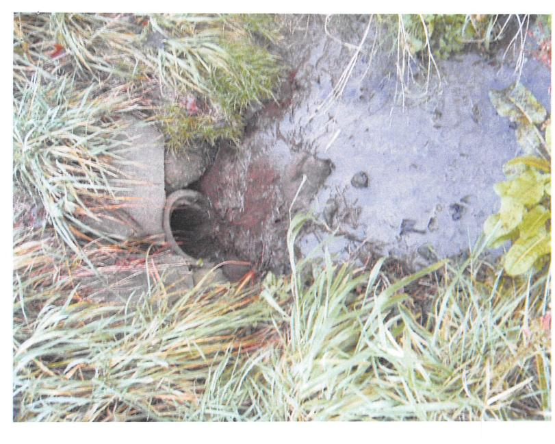
VIEW OF CULVERT UNDER THE EXISTING DRIVEWAY.
